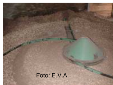
Schneckenaustrag mit Blattfederrührwerk
