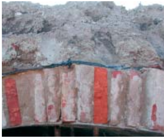
Deckenaufbau: Gewölbe mit aufgeklebter Sperrbahn (schwarz)
