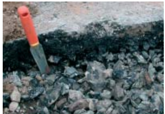
Anschnitt einer Schwarzdecke
