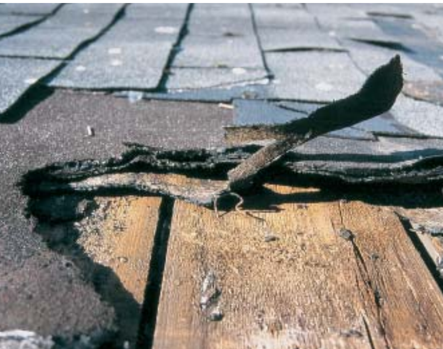
Dachpappe auf Holzschalung
