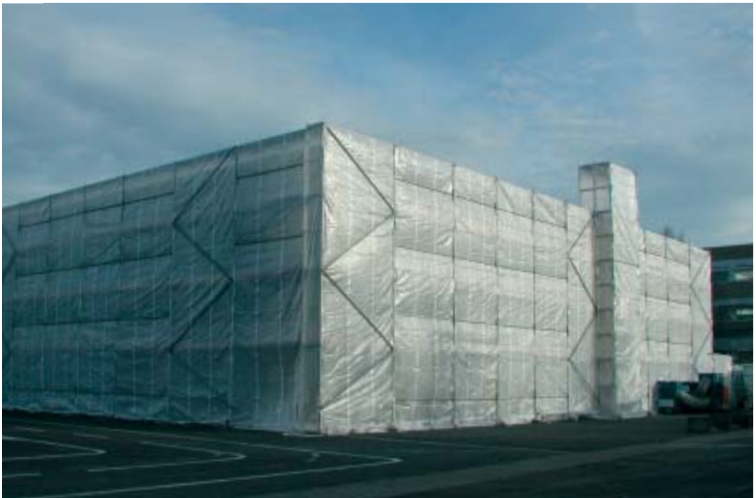
Vollständige Einhausung eines Gebäudes während der Sanierung
