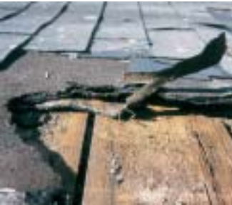
Dachpappe auf Holzschalung
