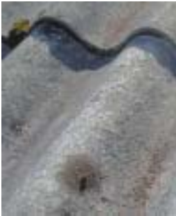
verwitterte Asbestzementplatte
