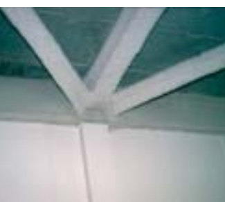
Stahlträger mit Spritzummantelung
