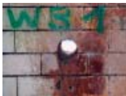
durchkernte Zwischenmauer
