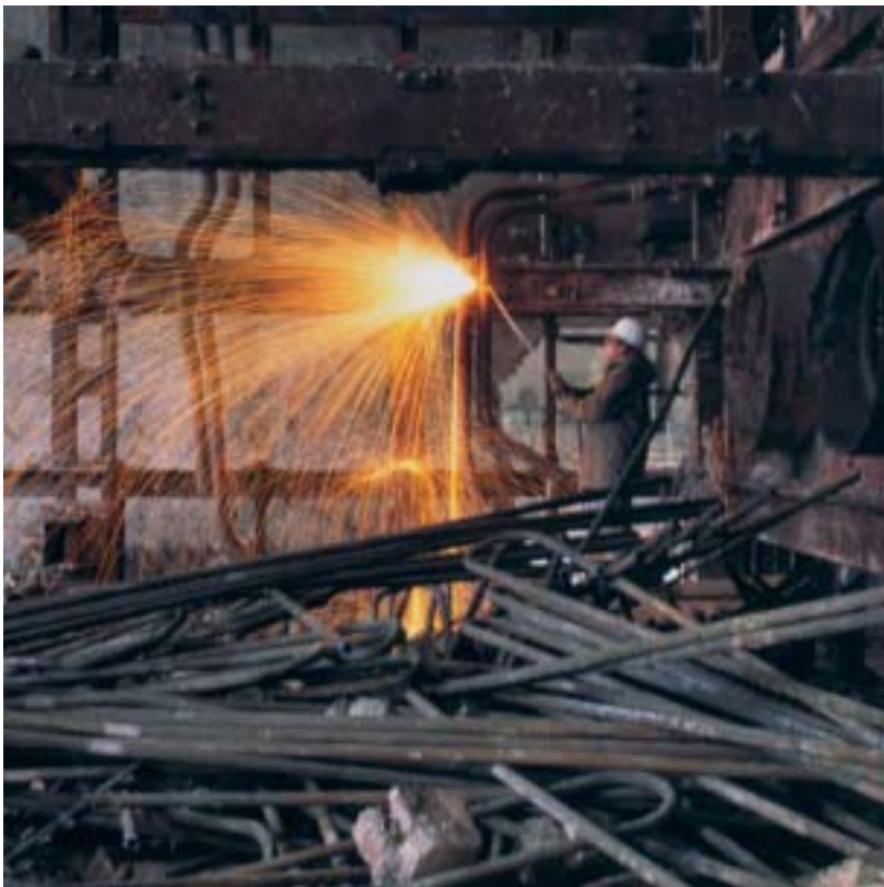
Demontage von nutzungsbedingten Einbauten
