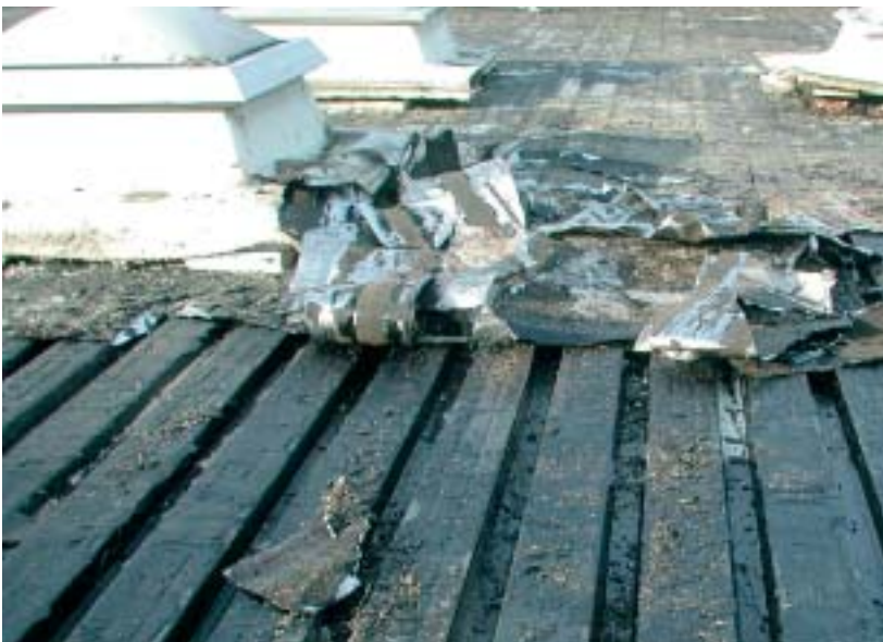
Dachpappe aufgeklebt auf Trapezblech
