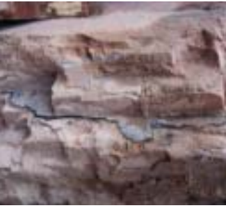
gemauerte Wand mit schwarzer Sperrbahn gegen aufsteigende Feuchtigkeit
