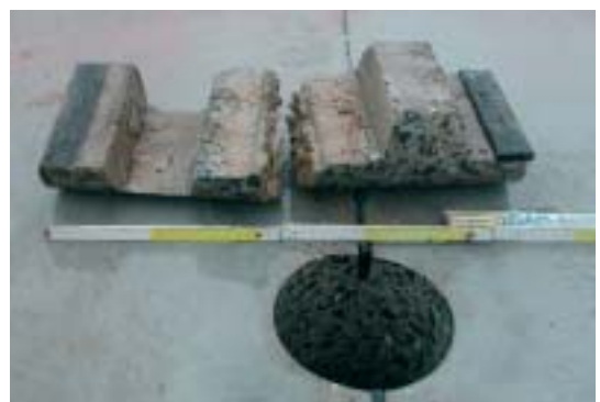
Fugenverguss zwischen Betonplatten
