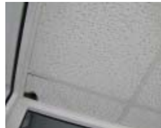
Deckenfaserplatten
