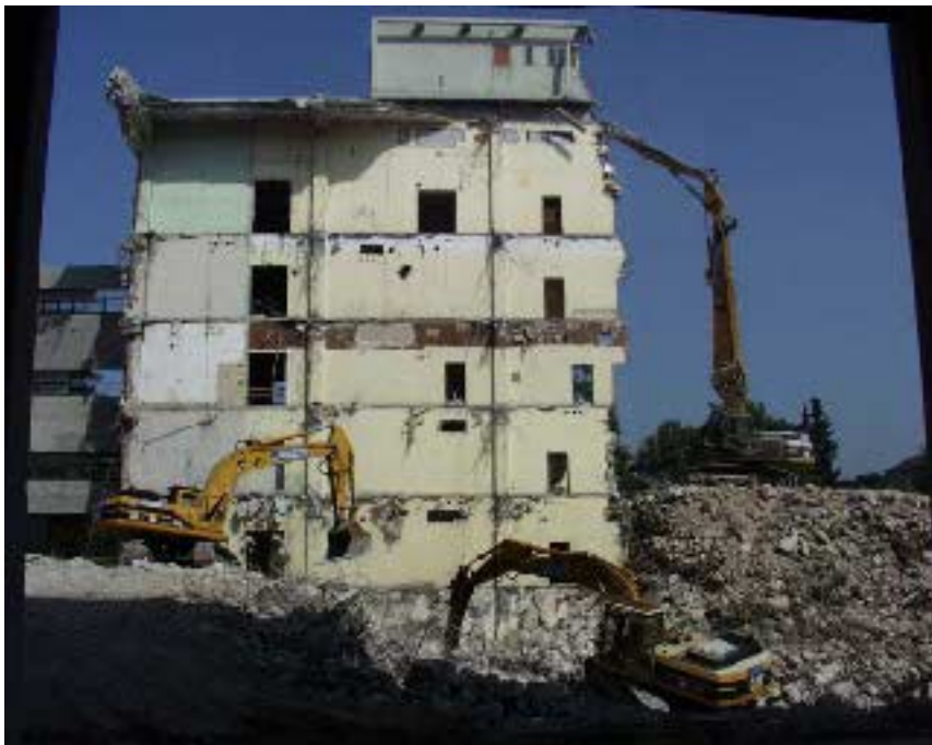
Abb. 1: kontrollierter Gebäuderückbau im Zuge einer Flächenrecycling-Maßnahme
